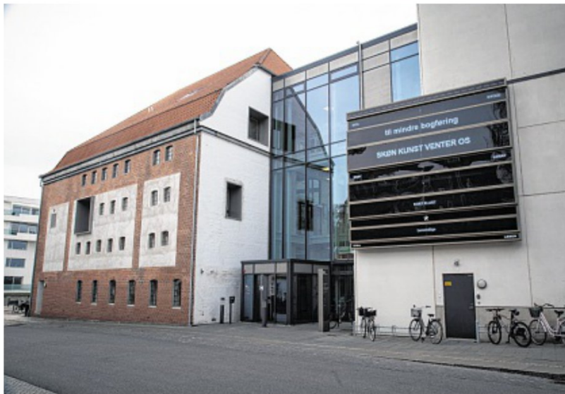
Der Eingang zum Multikulturhaus an der Nørre Havnegade.
